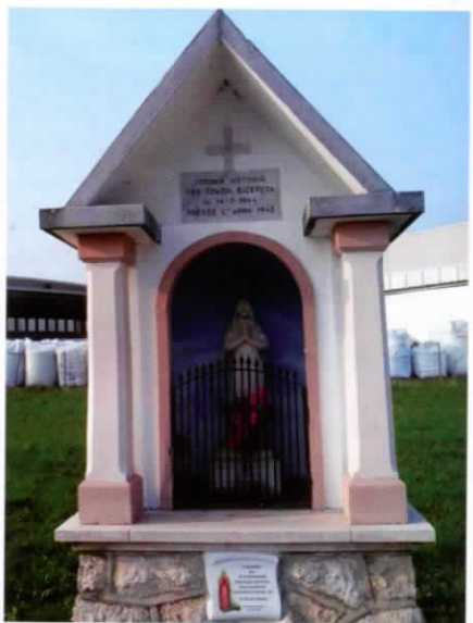
Il Capitello, oggi, dopo alcuni lavori di ristrutturazione
