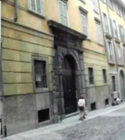
L'edificio dov'era il collegio delle Suore della Sapienza di Bergamo
