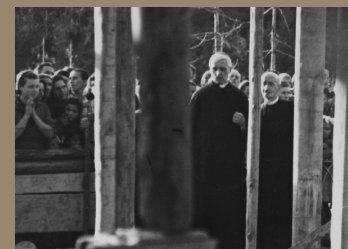
Mons. Bernareggi mentre osserva i lavori in corso alla Cappelletta
